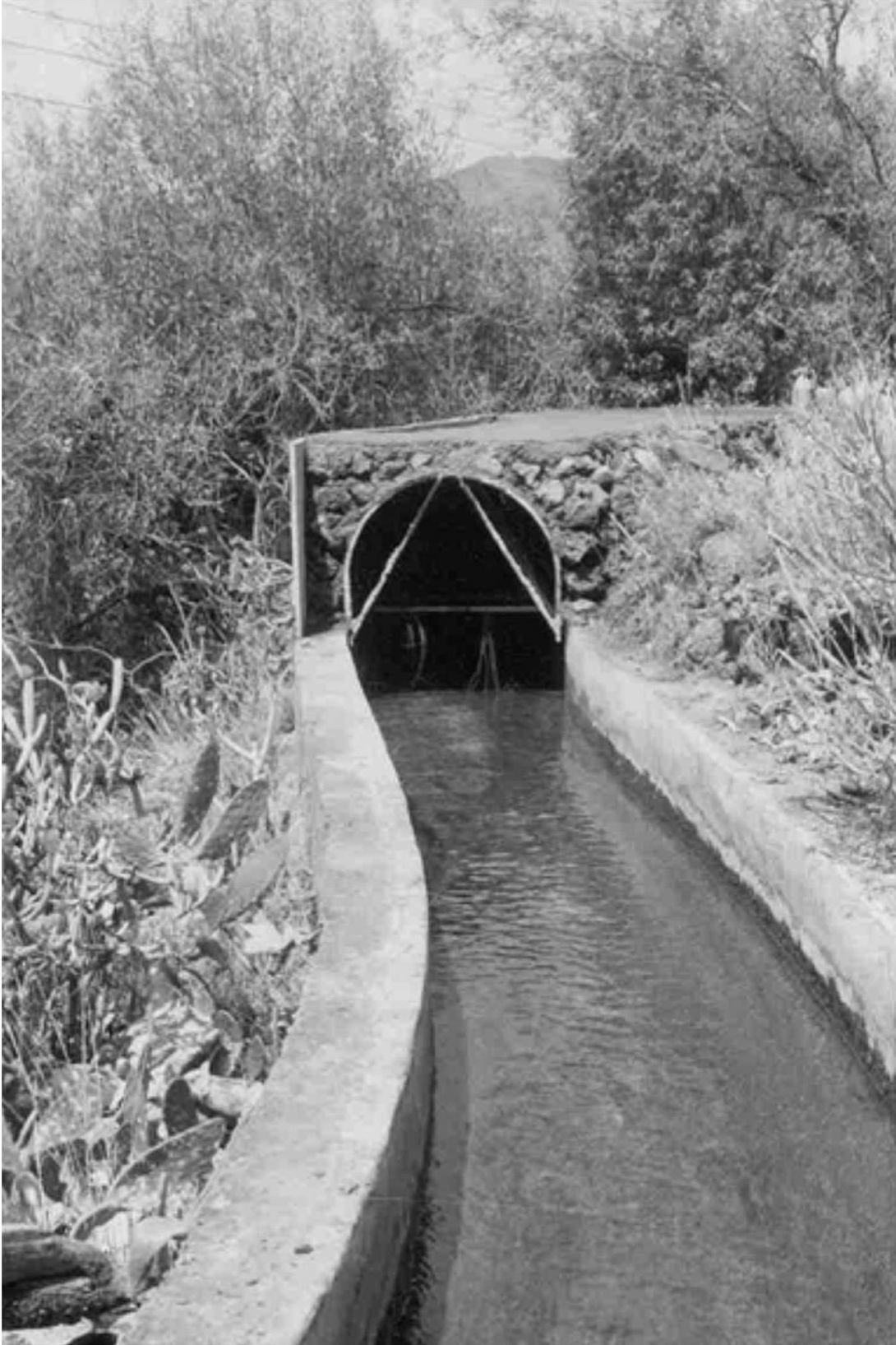
Fig. 20. Detalle del canal Dos Aguas – Los Barros en el que se observan las obras de recubrimiento que evitan daños provocados por los desprendimientos.
