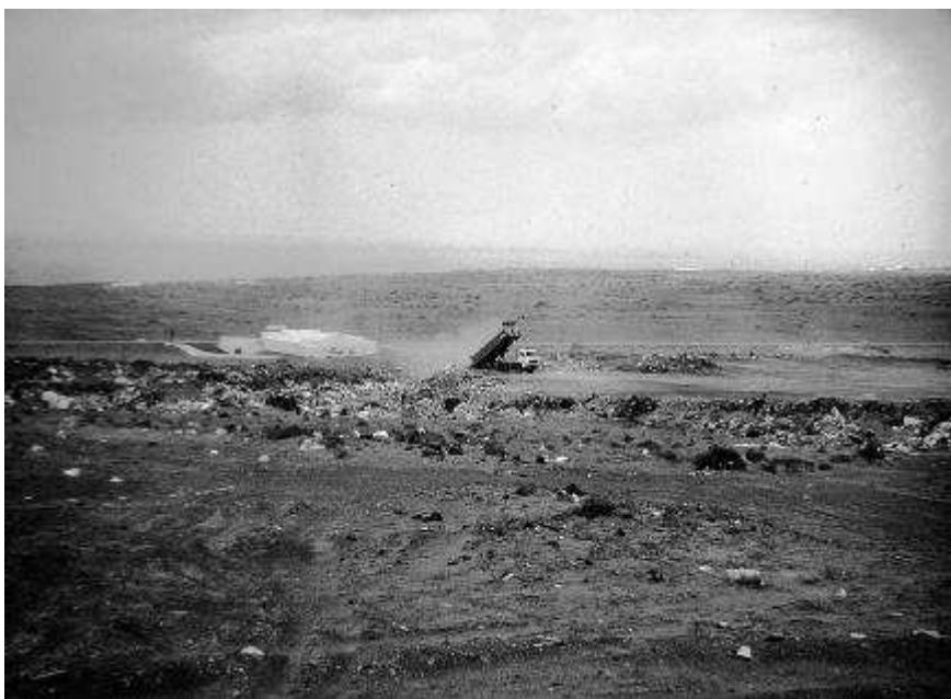
Fig. 20. Vertedero de escombros y otras infraestructuras públicas que obstaculizan el corredor del jable en Lanzarote (fotografía del autor).
