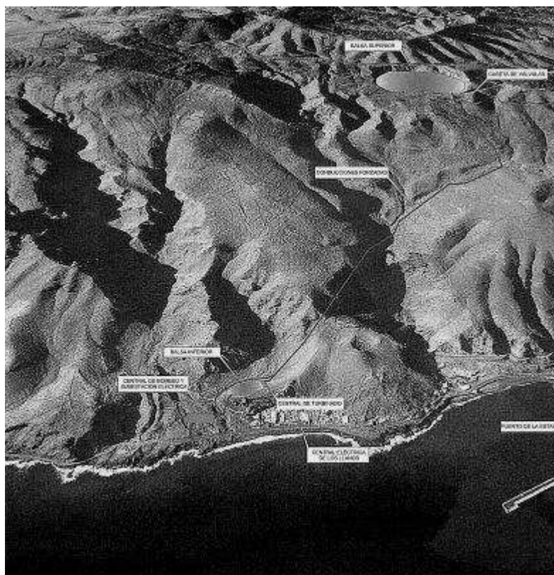
Fig. 21. Sistema hidroeléctrico del proyecto El Hierro 100% Renovable (imagen de Gorona del Viento El Hierro, S.A.).
