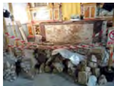
Desarrollo de las obras de restauración
