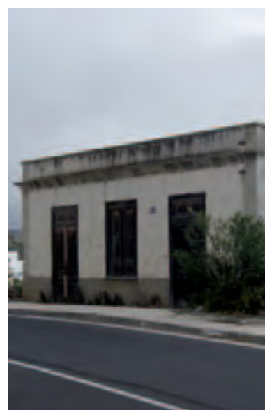
Vivienda alineada a la carretera.
