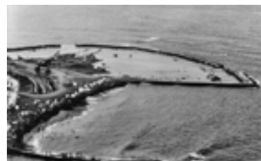
Construcción del Lago Martiánez.
