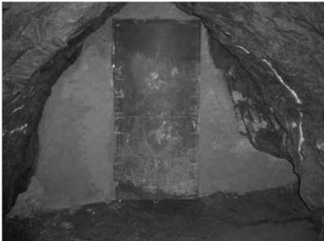
Fig. 13. Diferentes aspectos de las obras de cierre de la galería. En la imagen superior se observa el muro de hormigón visto desde la bocamina. Abajo, un cierre visto desde el frente de la galería.
