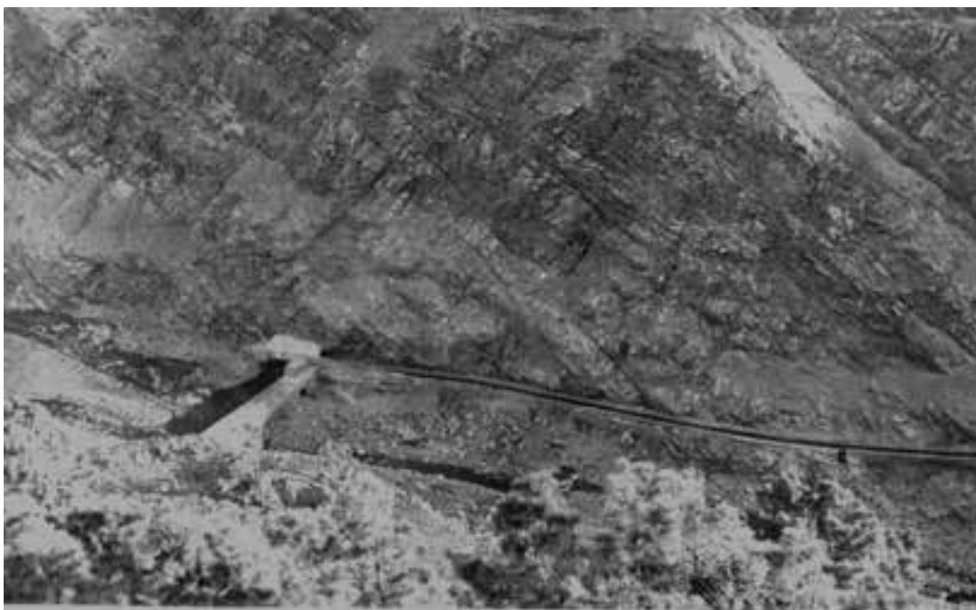
Fig. 14. Visión panorámica del tomadero de Dos Aguas construido en el cauce del barranco. Este es el tomadero más importante de La Caldera y a partir de él parte el canal Dos Aguas – Los Barros.
