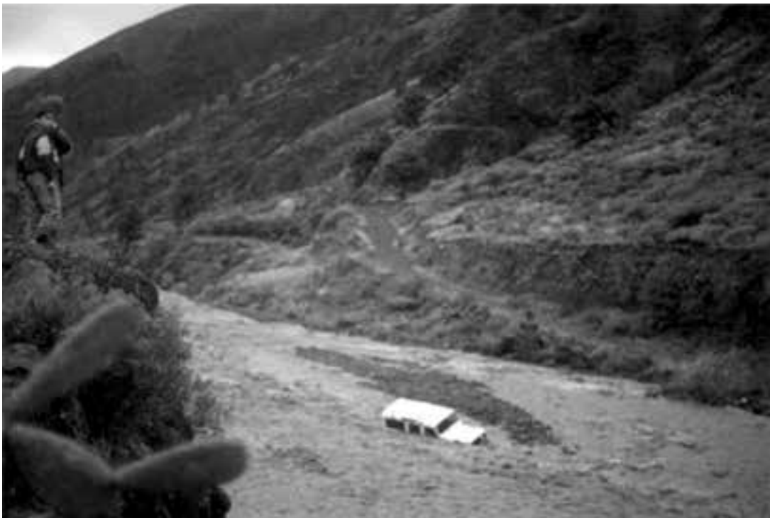
Fig. 16. Temporales con intensos aguaceros en la parte alta de La Caldera pueden provocar la circulación de violentos caudales de agua que provocan efectos erosivos importantes, con grandes derrumbes que represan las aguas. Cuando el agua de lluvia represada supera el derrumbe, agua y piedras se movilizan violentamente por el cauce del barranco de Las Angustias camino del mar.
