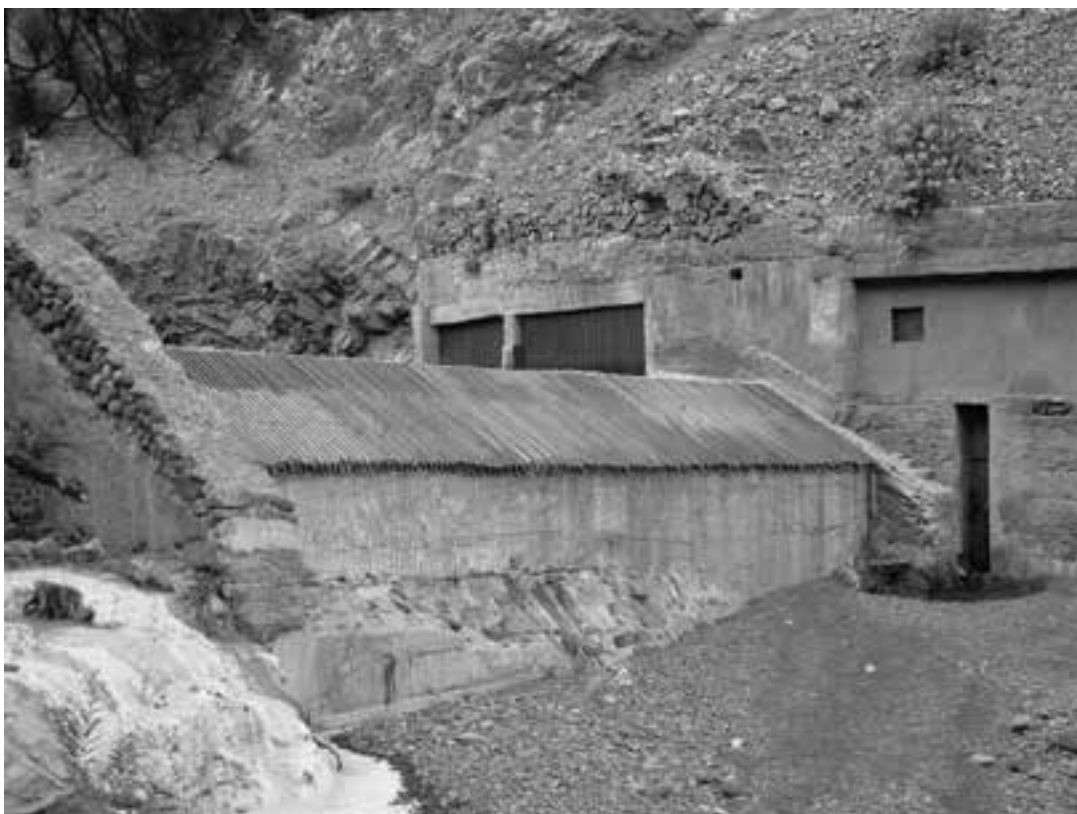
Fig. 17. El tomadero de Dos Aguas está formado por un cierre incrustado en el basalto. En la parte superior tiene unas rejas de acero en forma de rastrillo, por las cuales se filtra el agua y las arenas que la acompañan.
