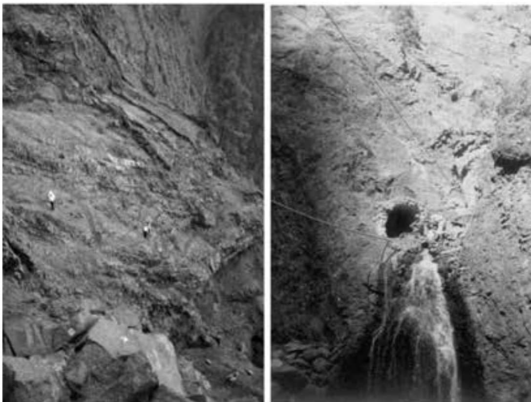
Fig. 10. La accidentada orografía de La Caldera con paredones de muy difícil acceso ofreció elevadas dificultades para llevar a cabo el trabajo de perforación de las galerías.
