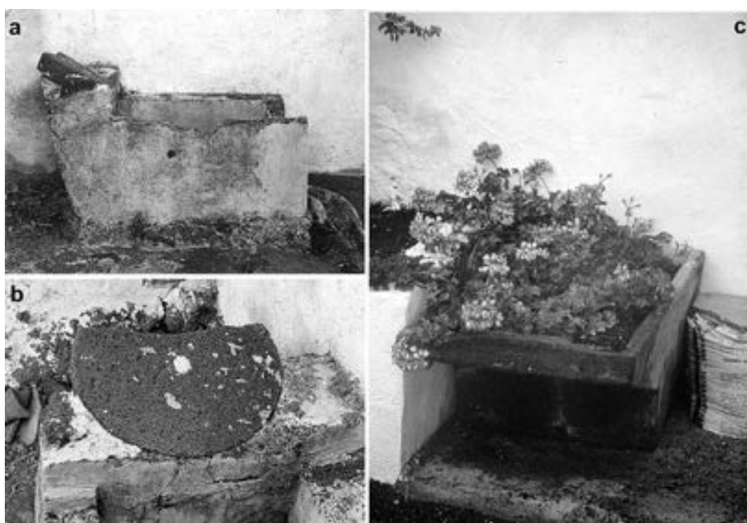
Fig. 17. Pila de lavar construida en cemento (a); detalle de la pila de lavar, con una antigua piedra de molino incrustada para servir de 'batidera' (b); y antigua pila de lavar reconvertida en jardinera (c) (fotografías del autor).
