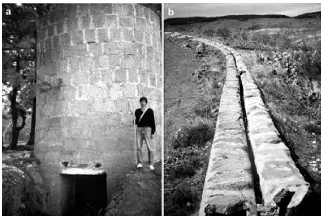
Fig. 19. Horno de cal en los Altos de Arico (a); y atarjeas para el transporte de agua (b). El horno aprovechaba las sales calcáreas contenidas en el agua (fotografías del autor).
