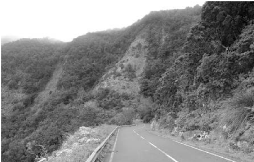
Fig. 17. Avalanchas sobre laderas empinadas.
