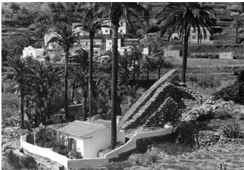
Fig. 57. Molino de En Medio, Guadá, transformado en una vivienda. Todavía conservaba el jerío, la escalera y parte de la tarjea a nivel.
