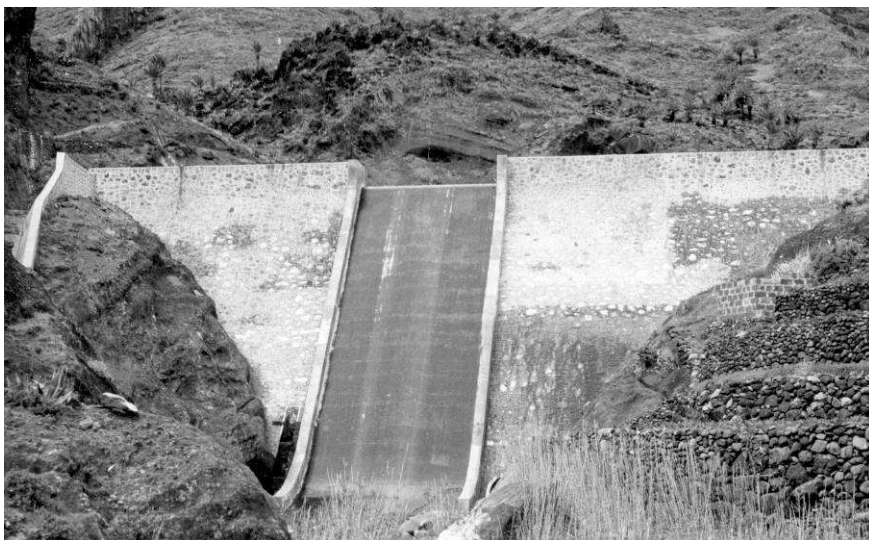
Fig. 14. Presa de Iscagüe en La Gomera (JG)
