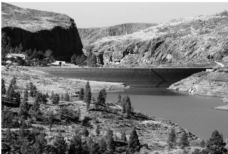
Fig. 18. Presa de Chira en Gran Canaria (JG)
