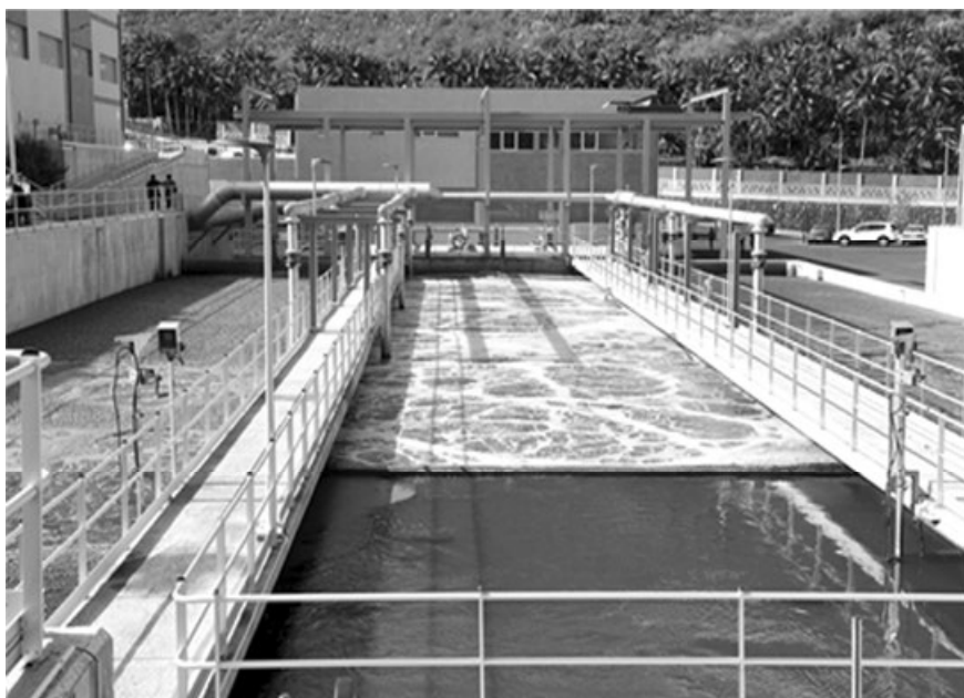
Fig. 6. Biorreactor de membranas de la EDAR del Noreste de Tenerife con tanque de membranas al fondo.
