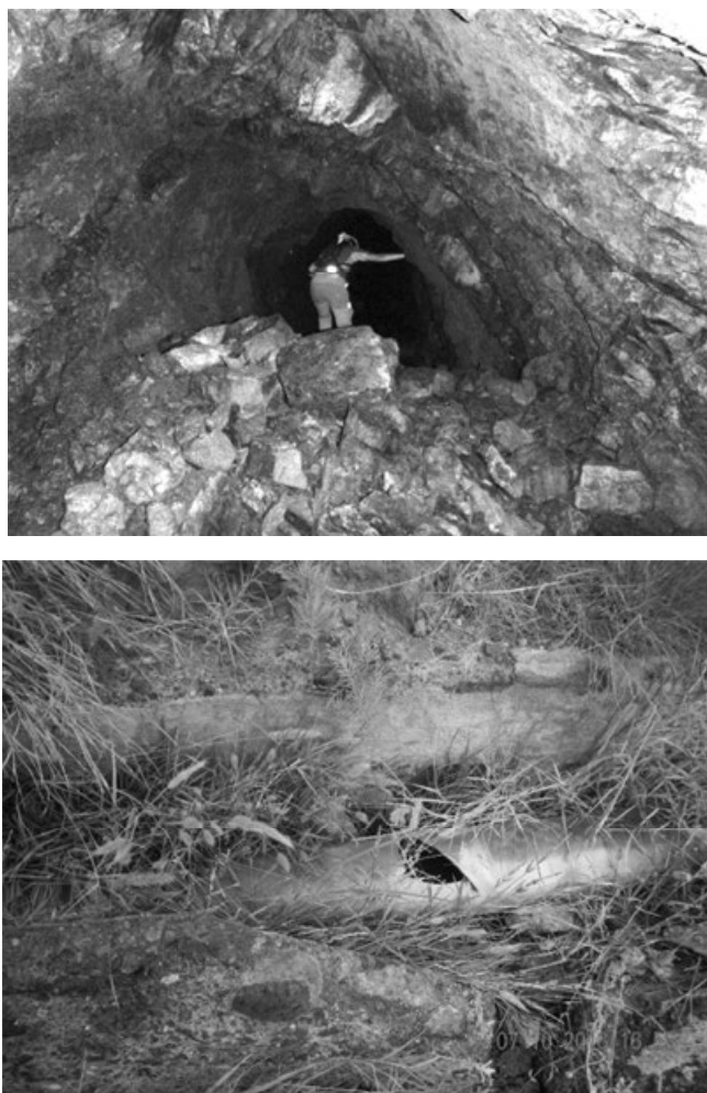
Fig. 9. Derrumbe interior de una galería (arriba) y tubería de transporte en mal estado (abajo).
